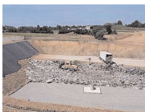
Site d'enfouissement de Laval (54)
